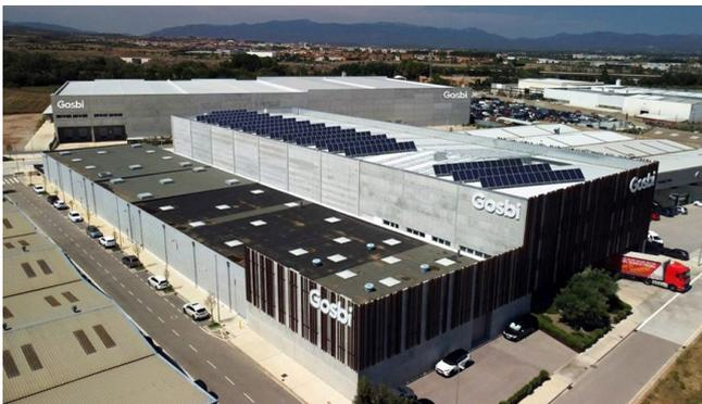
Vista aérea de las naves de Gosbi Pet Food. La nave posterior, con una superficie total de 8.000 m<sup>2</sup>, integra un innovador sistema de transporte y almacenamiento automático con AGVs y sistema Pallet Shuttle de STILL.
